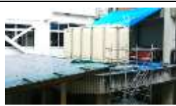
雨天時:ビニールシートを掛けて作業
